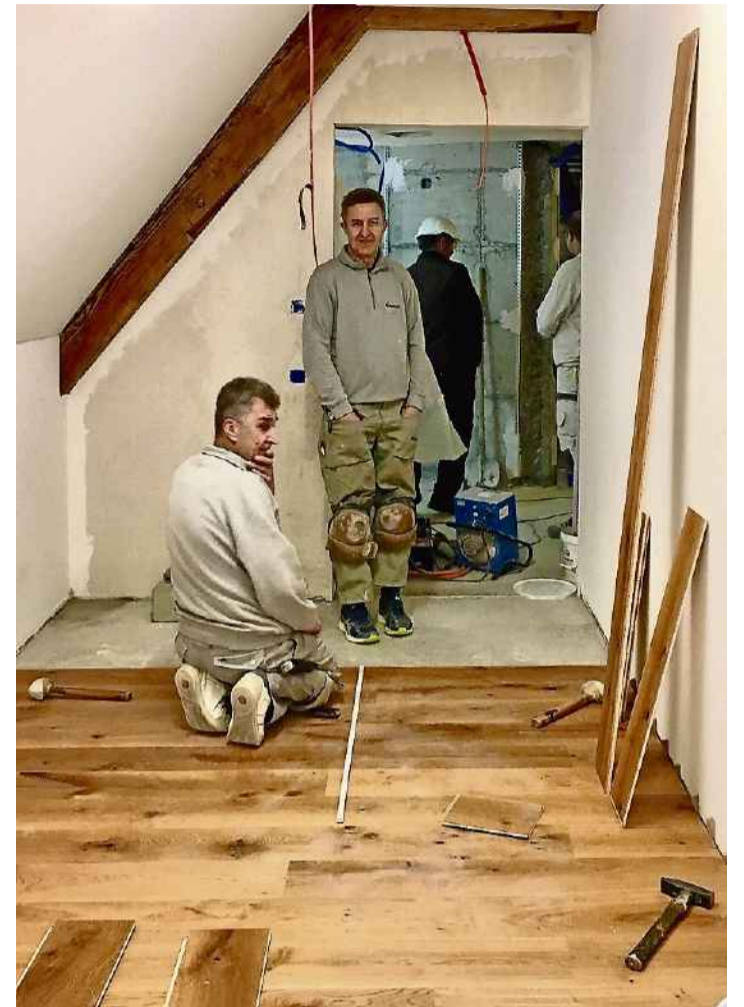
Handwerker verlegen beim Innenausbau einen neuen Boden.
